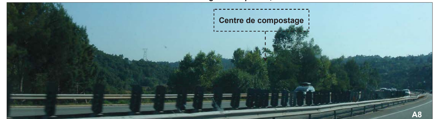
Photo n°26 - Vue à proximité du centre, direction Aix-en-Provence
