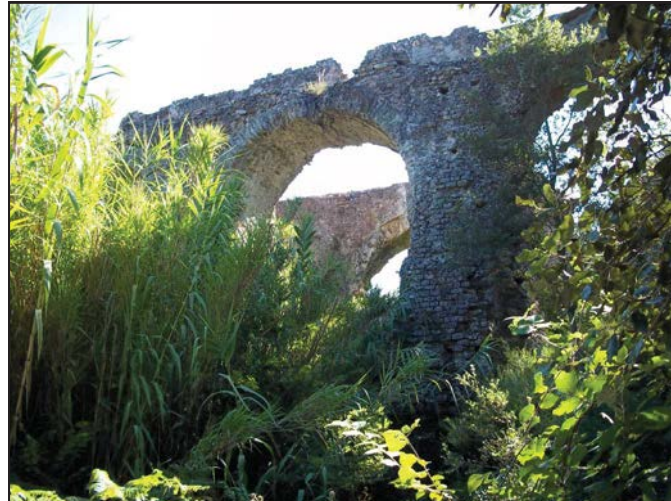
Photo n°08 - Vue sur les arches Sénéquieres (Viaduc romain)
