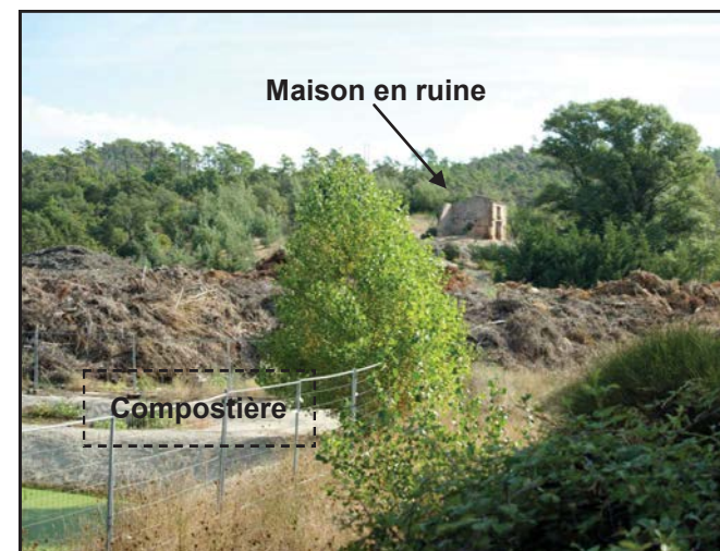
Photo n°13 - Vue sur la maison en ruine, depuis la compostière
