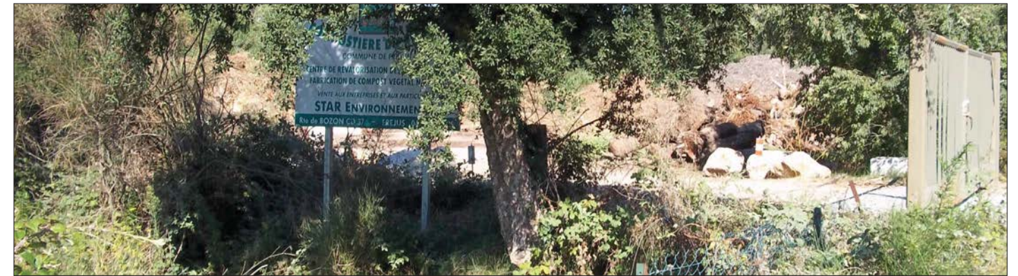
Photo n°01 - Vue depuis la départementale D37 sur l'entrée du centre de compostage
