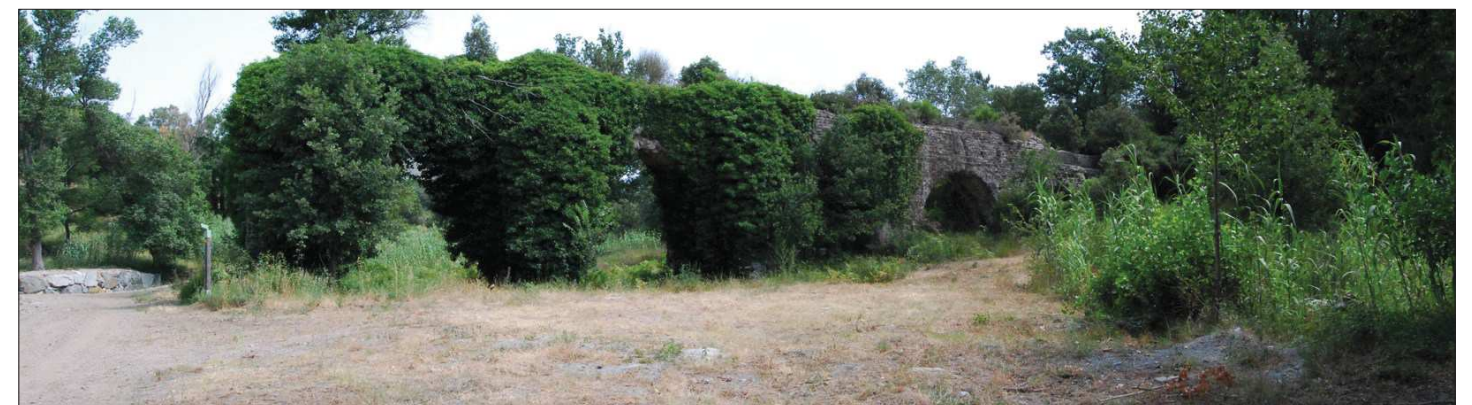
Photo n°15 - Vue depuis les vestiges du viaduc romain
