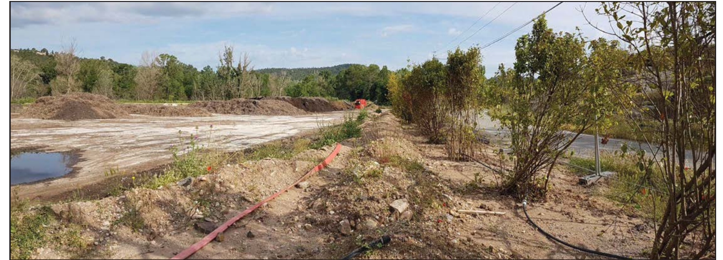
Photo n°A - Vue depuis la départementale D37 sur l'entrée du centre de compostage (mai 2018)
